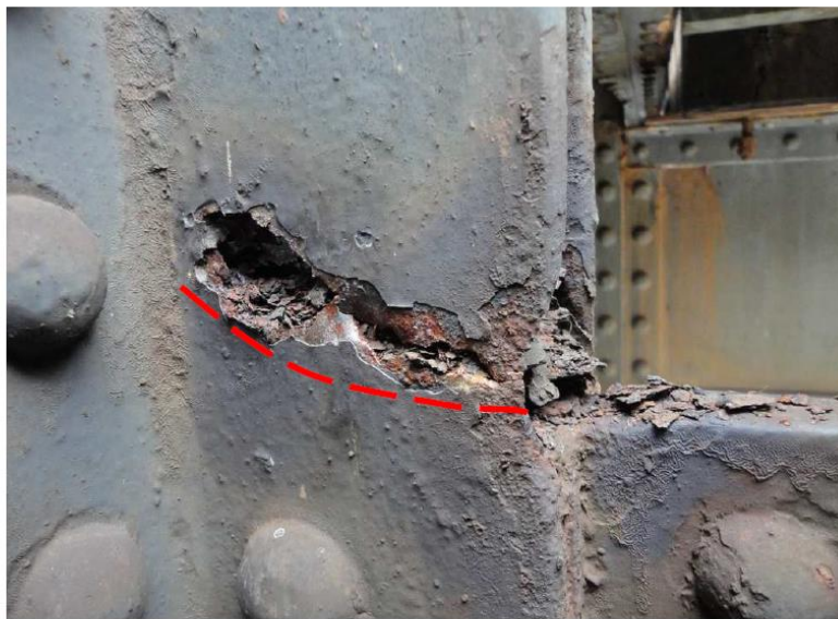
Koroze v přípojkách svislic a diagonál ke styčnickovým plechům dolního pásu
