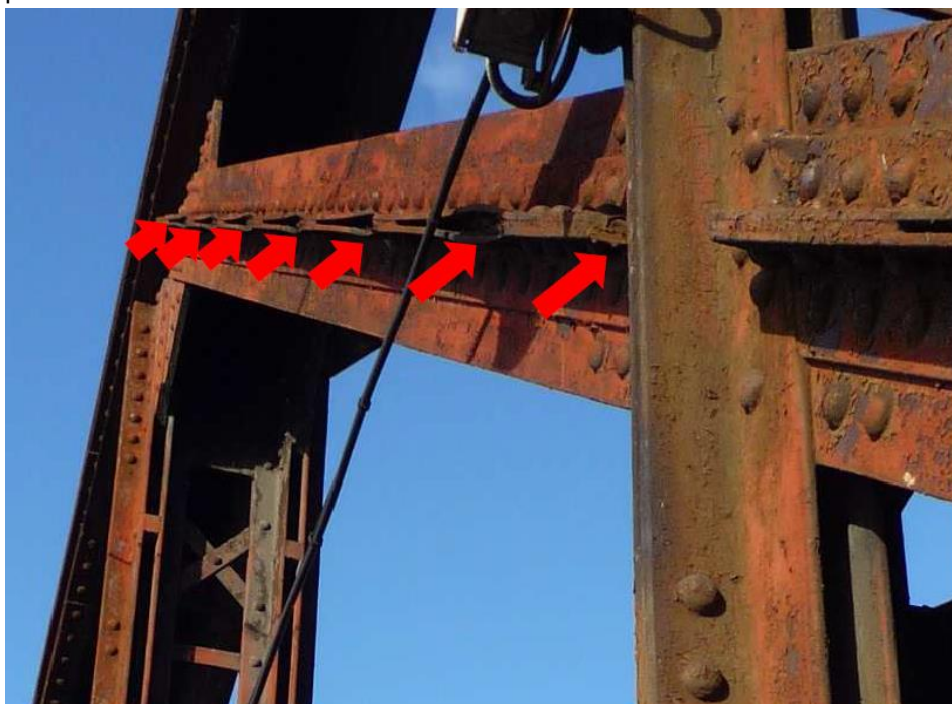
Silná štěrbinová koroze v přípojkách spojek členěných prutů svislic a diagonál
